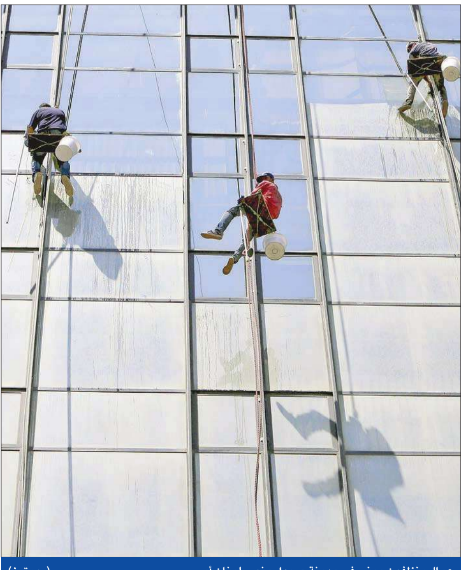
عمال ينظفون مبنى في مدينة صيدا جنوب لبنان أمس (رويترز)
