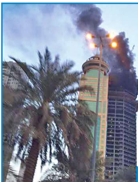
النيران تندلع في المبنى
