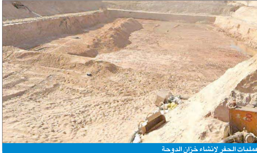
عمليات الحفر لإنشاء خزان الدوحة
