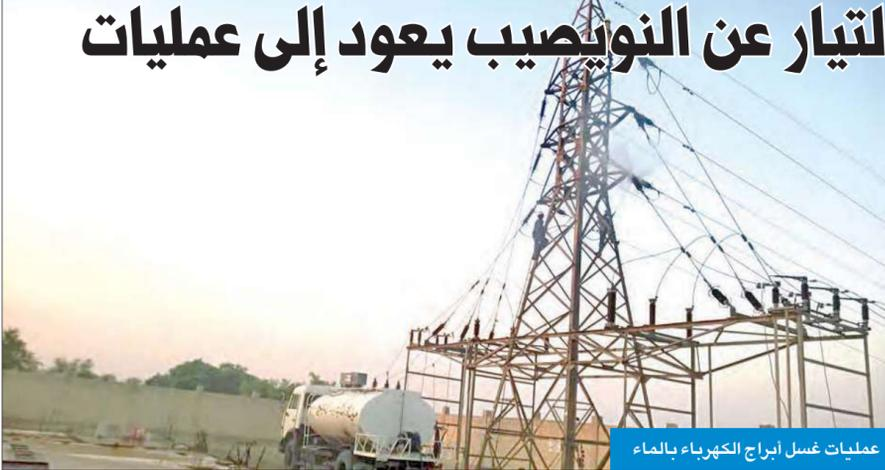
عمليات غسل أبراج الكهرباء بالماء
