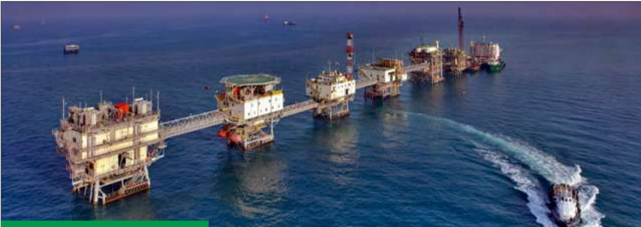
مشآت لإحدى عمليات منطقة الخفجي
