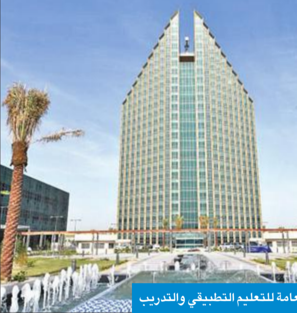
مبنى الهيئة العامة للتعليم التطبيقي والتدريب
