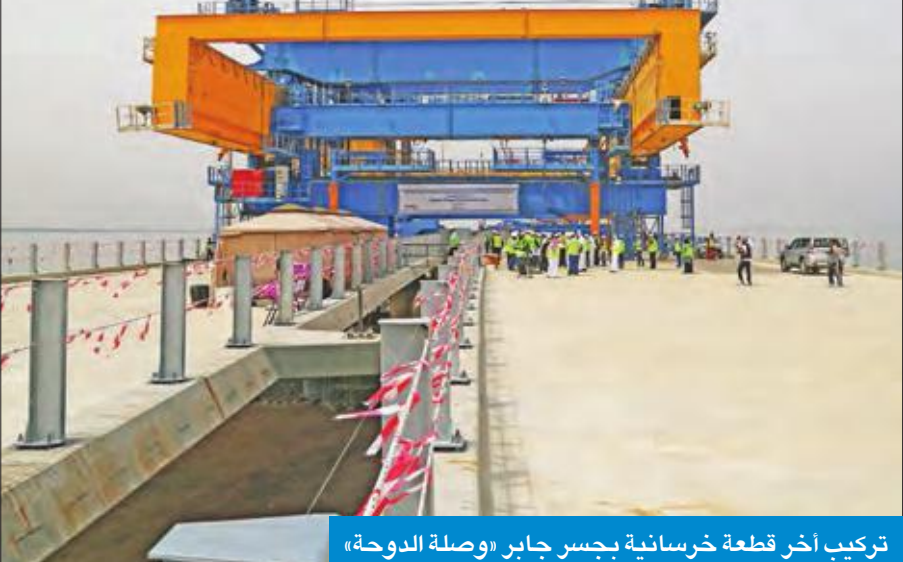
تركيب آخر قطعة خرسانية بجسر جابر «وصلة الدوحة»
