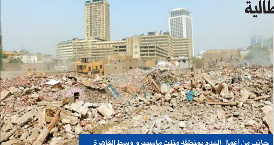
جانب من أعمال الهدم بمنطقة مثلث ماسبيرو وسط القاهرة
