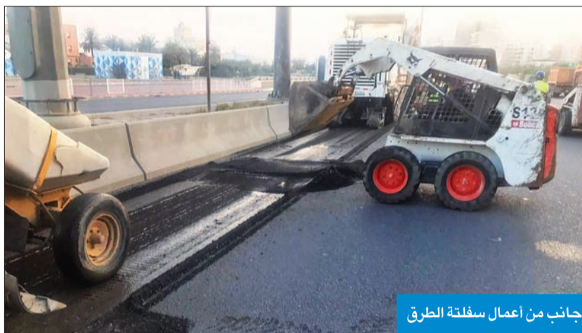
جانب من أعمال سفلتة الطرق
