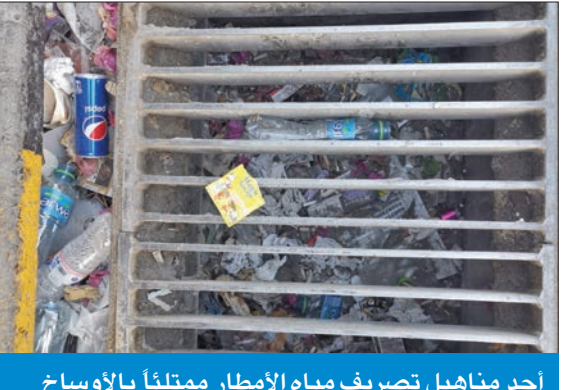
أحد مناهيل تصريف مياه الأمطار ممتلئاً بالأوساخ
